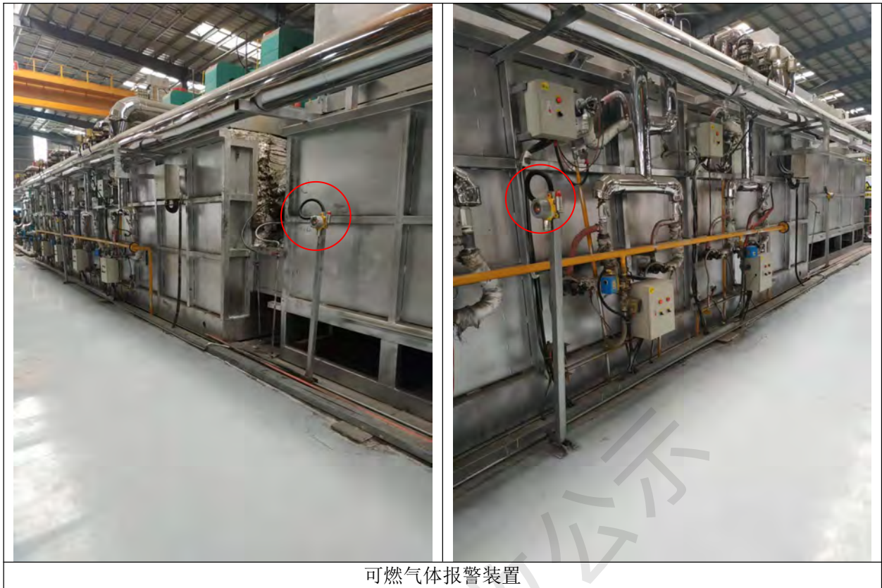
图 4.6-2 可燃气体报警装置
