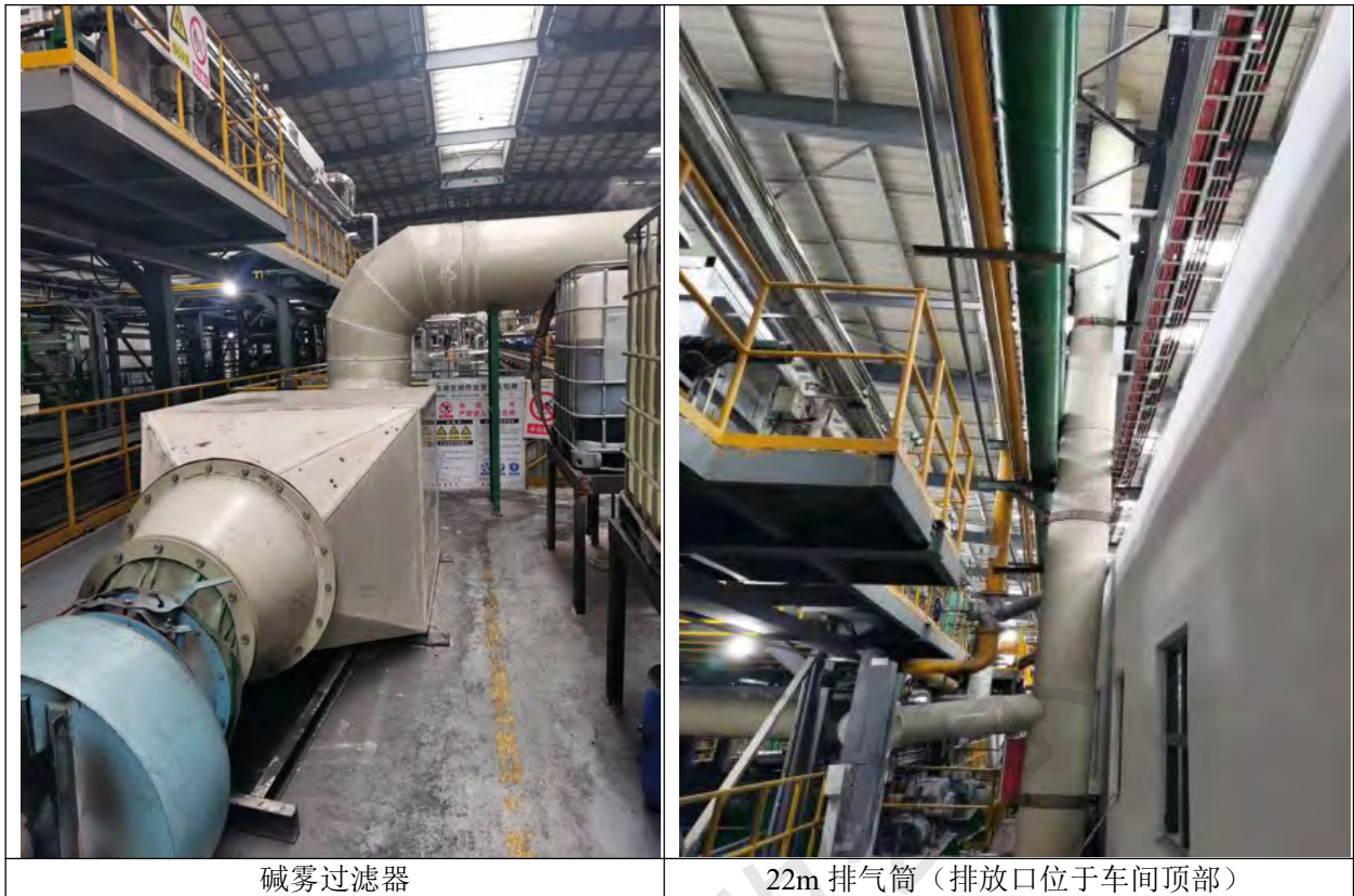
图 4.1-6 脱脂清洗碱雾处理设施
